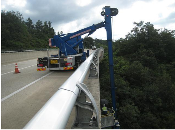
굴절점검차를 이용한 근접조사
