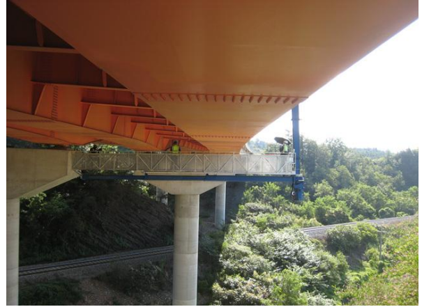
굴절점검차를 이용한 근접조사
